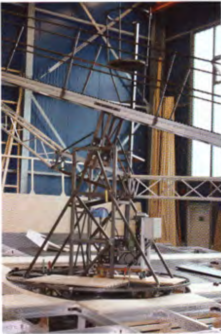
Die Stahlskulptur im Bau
